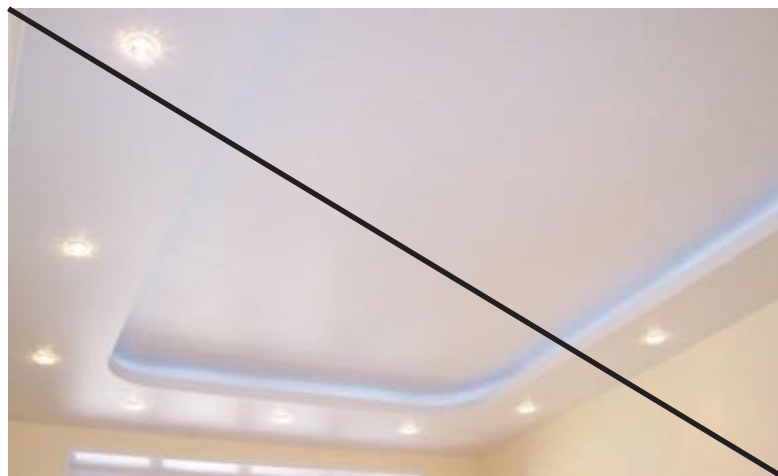
Плохо Многоуровневые гипсокартонные конструкции
