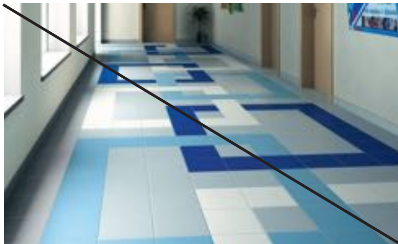
Плохо Цветные вставки из плитки
